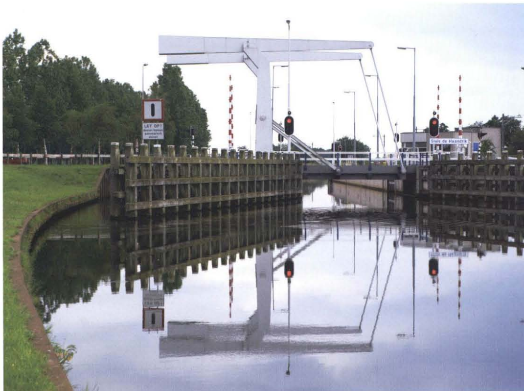
Het eerste deel van het kanaal Almelo-De Haandrik tussen Vroomshoop en de Vecht kwam in 1858 gereed. Dit kanaal is een onderdeel van het Overijssels kanalenstelsel dat Thomas Stieltjes heeft ontworpen en laten graven. Ten behoeve van de scheepvaart wordt het waterpeil op niveau gehouden met sluisen, zoals hier met de brug en sluis bij De Haandrik.
