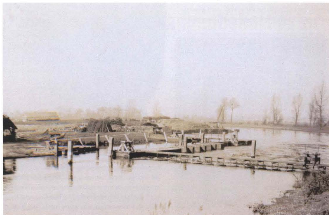
De eerste in 1853 gebouwde stuw op de Vecht bij 'De Haandrik'. Links naast de stuw is een schutsluis waardoor de rivier voor schepen bevaarbaar bleef. Door het opstuwen van het water op de Vecht kon het bovenstrooms gelegen kanaal Almelo-De Haandrik op peil worden gehouden. De huidige stuw en sluis is in 1921 gebouwd.
